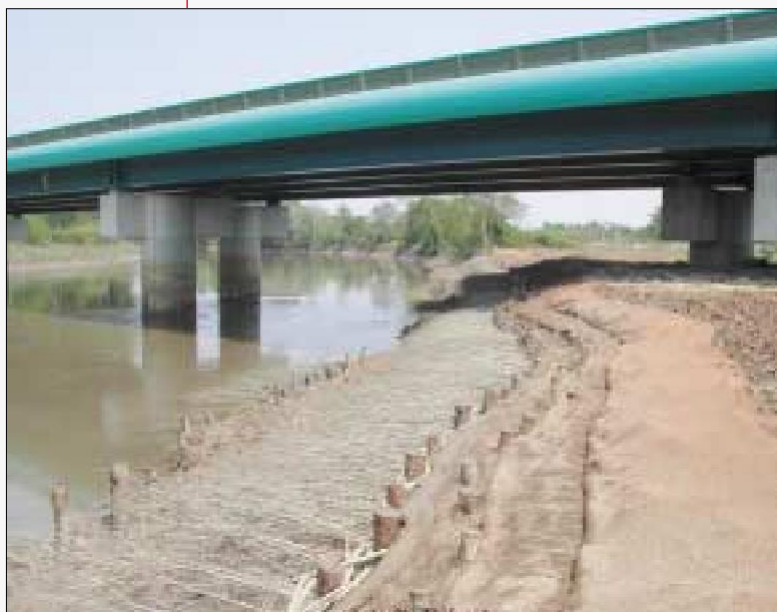
L'Ingénierie réalise des missions en génie écologique : ici la restauration des berges de l'Isle sur l'A 89.
